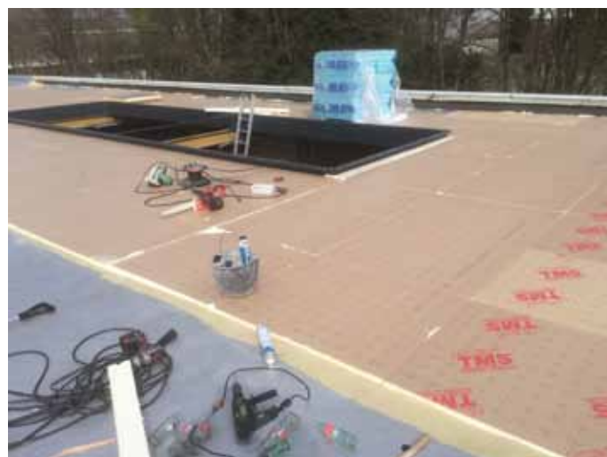
plaatsen van dakisolatie op industriegebouw van GT Foam
