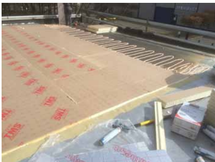
plaatsen van dakisolatie op industriegebouw van GT Foam
